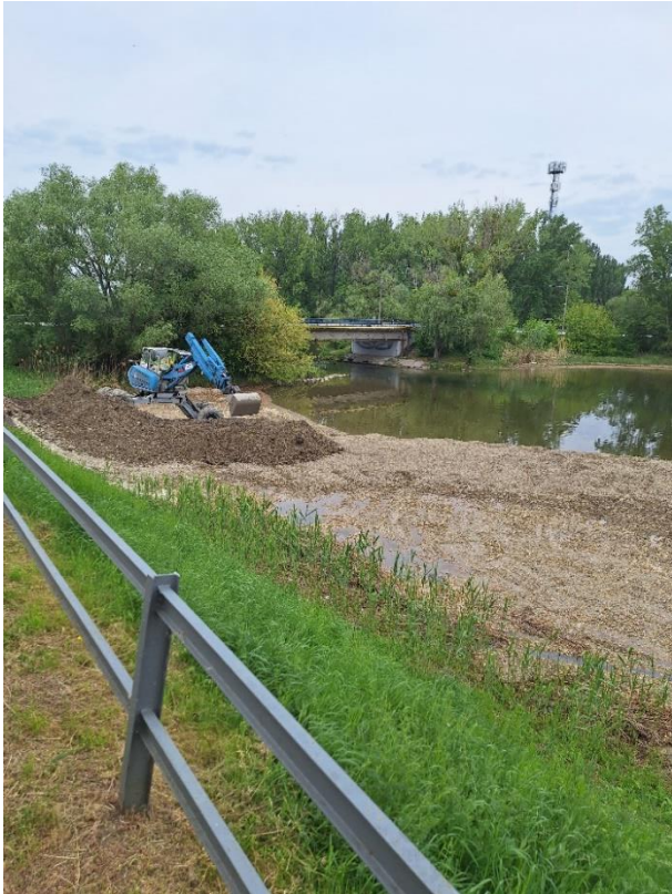
Úprava pláne štrkovej lavice č. 1
