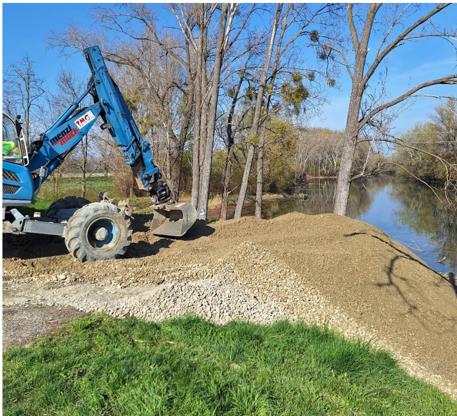
Budovanie dočasnej zjazdnej rampy a prístupovej komunikácie k ostrovu č. 1
