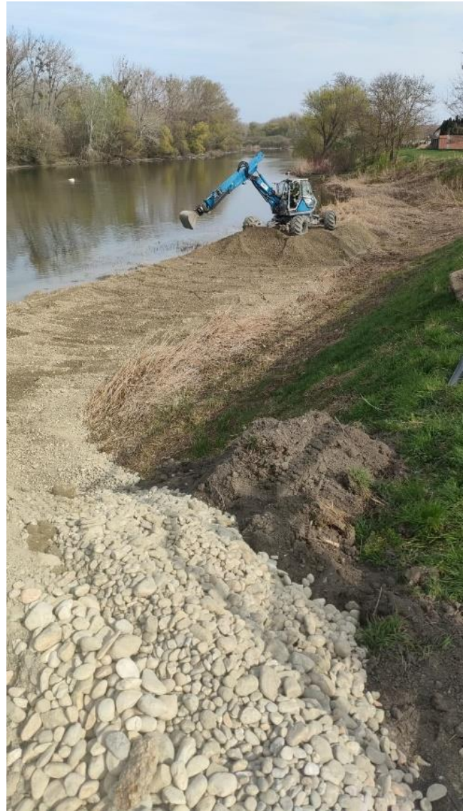
Úprava štrkovej lavice č.1
