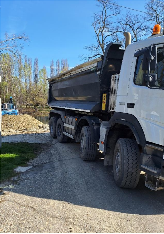
Budovanie dočasnej zjazdnej rampy k ostrovu č. 1
