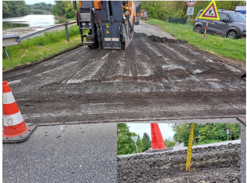
Frézovanie asfaltového krytu v hr. 50 mm
