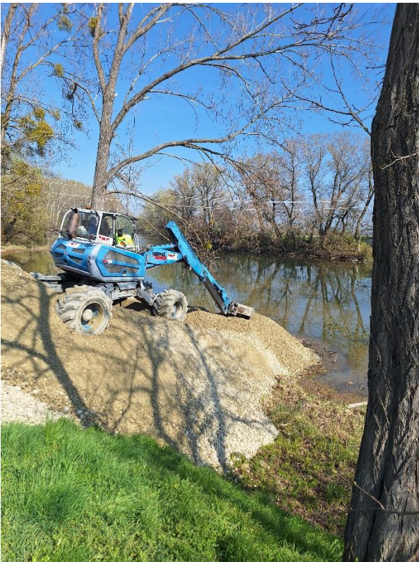
Svahovanie prístupovej rampy k ostrovu č. 1
