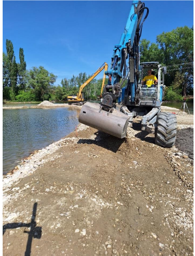
Násyp vyvýšeného chrbta
