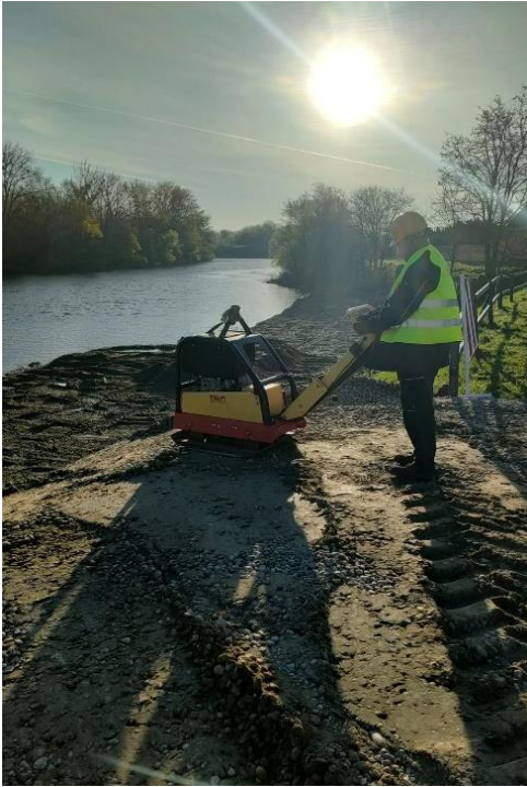
Hutnenie zjazdnej rampy k štrkovej lavici č. 1
