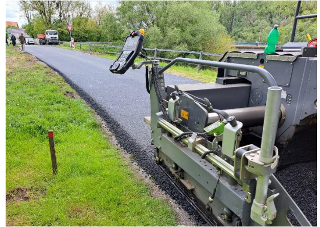
Asfaltovanie obrusnej vrstvy AC 16
