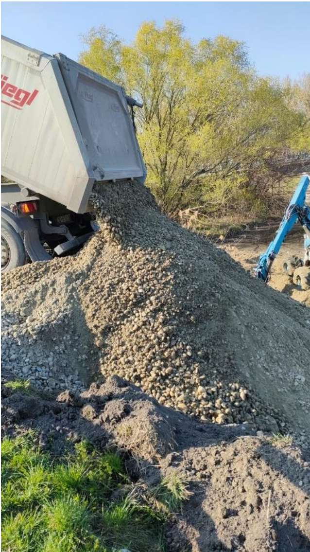
Násyp materiálu do štrkovej lavice č. 1
