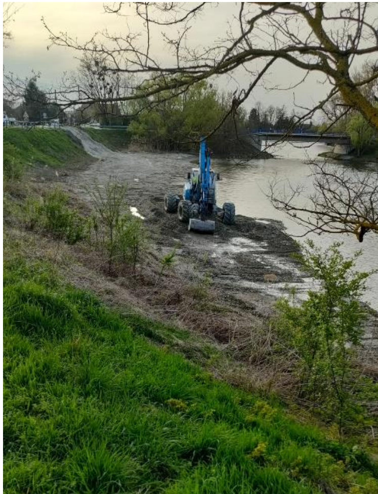
Úprava štrkovej lavice č. 1
