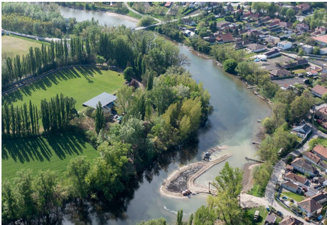
Pohľad na ostrov č. 1 a štrkovú lavicu č. 1 v priebehu výstavby
