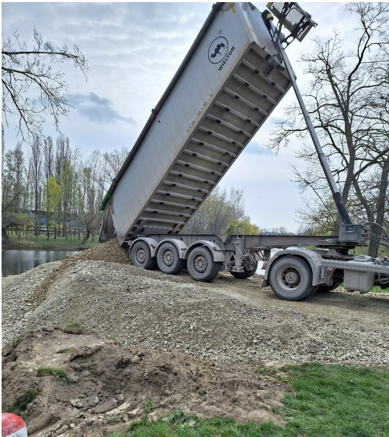
Násyp prístupovej komunikácie k ostrovu č. 1
