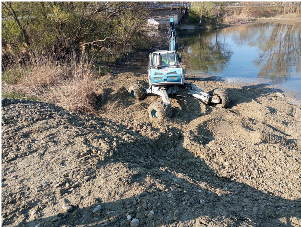
Začiatok sypania štrkovej lavice č. 1
