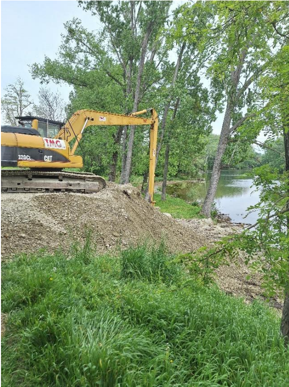
Odstránenie prístupovej komunikácie ostrova č. 1
