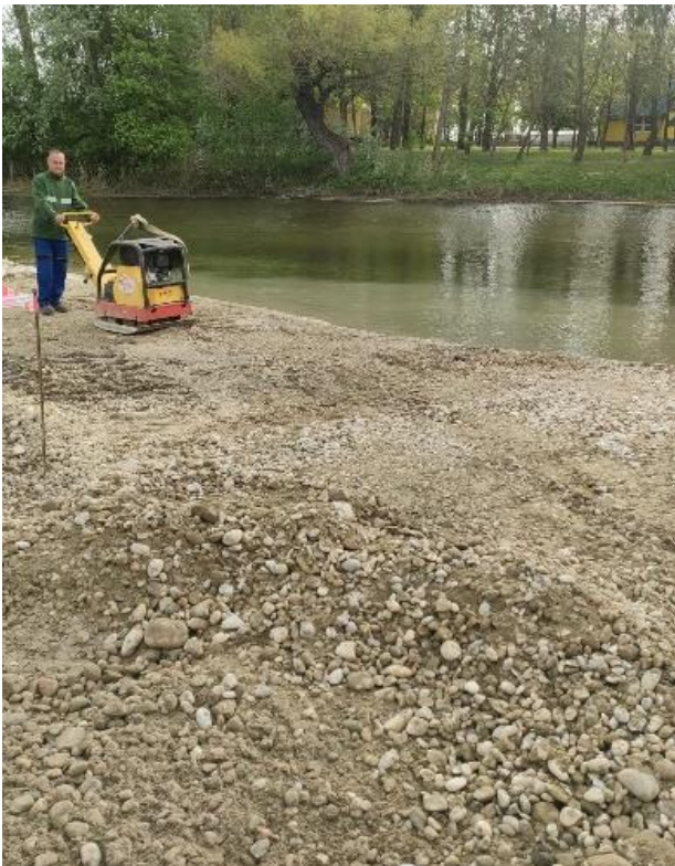
Úprava pláne štrkopieskového ostrovu č. 1 so zhutnením
