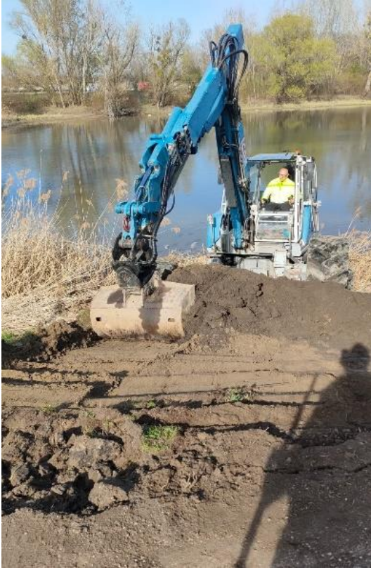
Odstránenie ornice na štrkovej lavici č. 1
