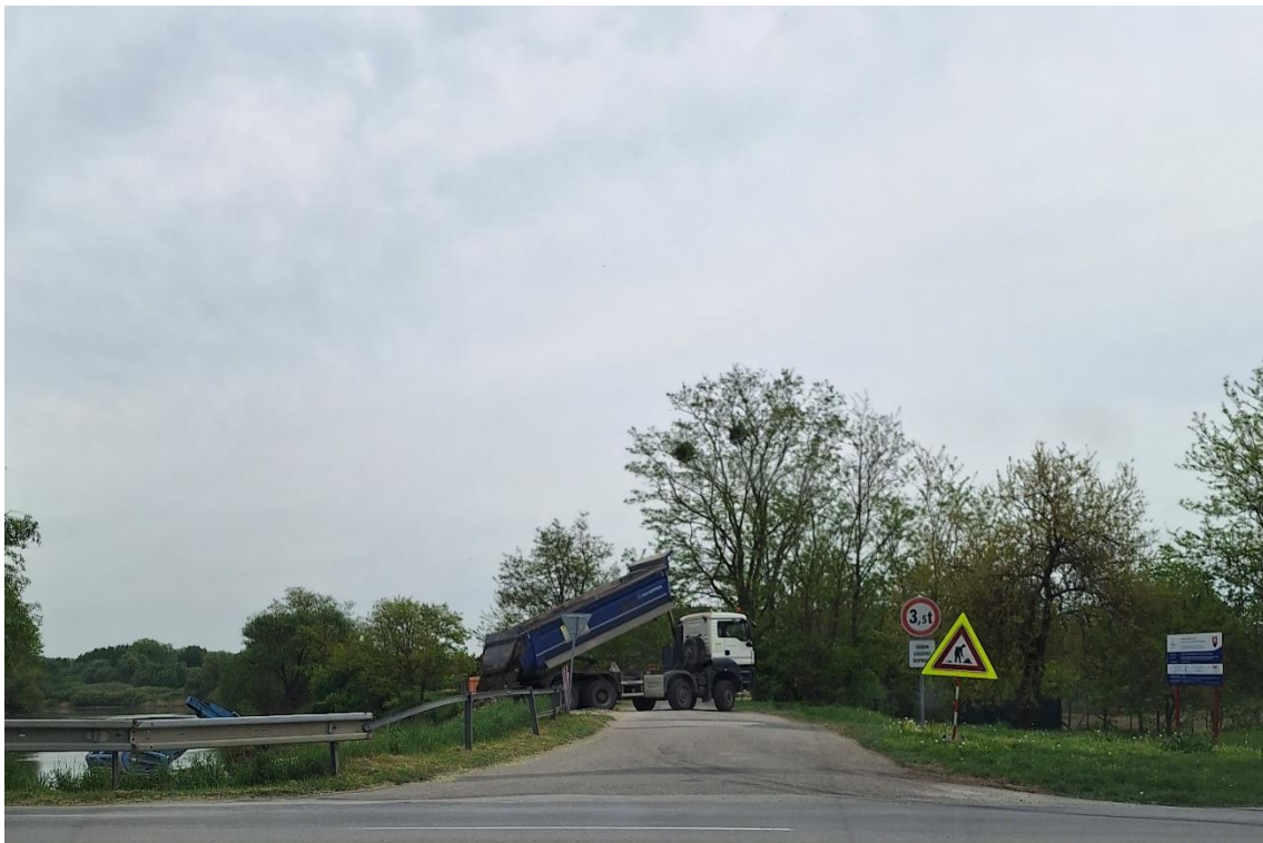
Presun materiálu z odstránenej prístupovej komunikácie ostrova č. 1 do štrkovej lavice č. 1
