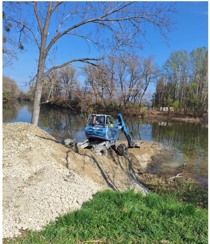
Budovanie dočasnej zjazdnej rampy a prístupovej komunikácie k ostrovu č. 1
