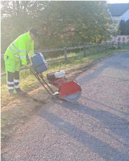
Rezanie existujúceho asf. krytu
