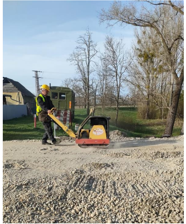
Hutnenie zjazdnej rampy k ostrovu č. 1
