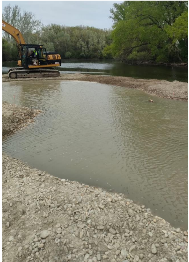
Budovanie obrysovej línie ostrova č.1
