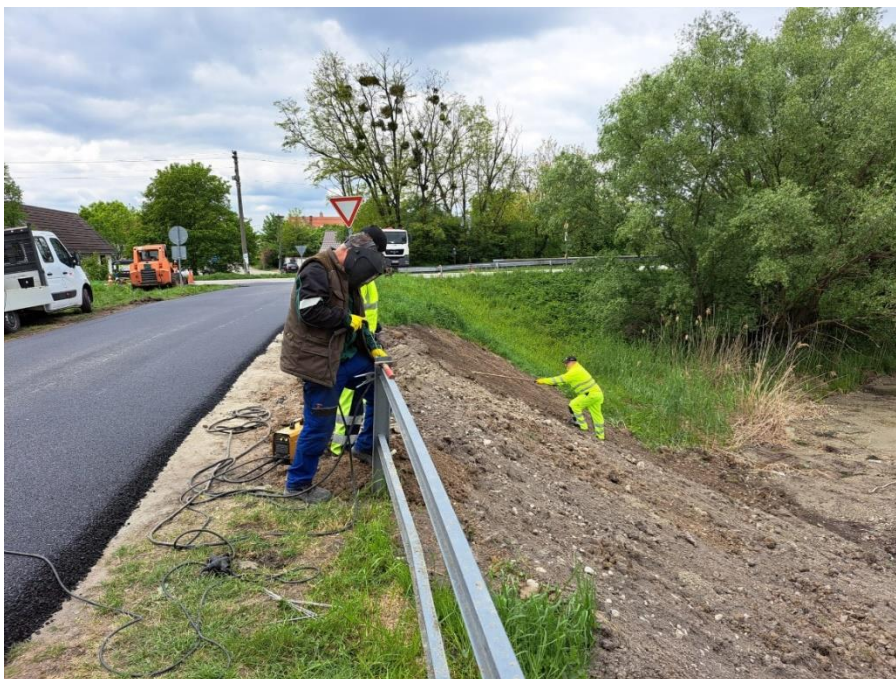
Spätná montáž cestného zábradlia
