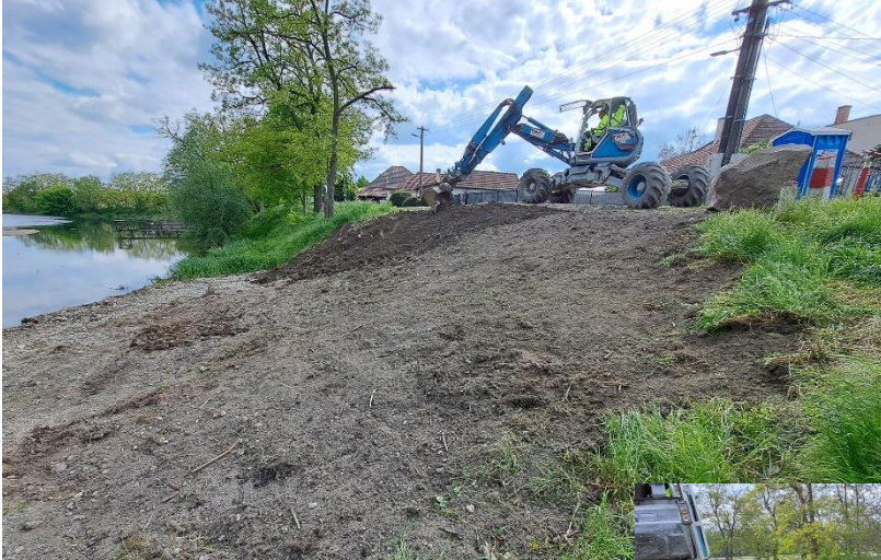
Rozprestretie ornice na svahu
