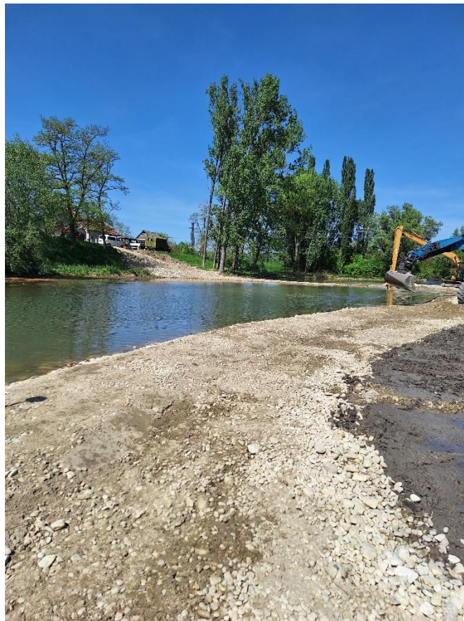
Násyp vyvýšeného chrbta
