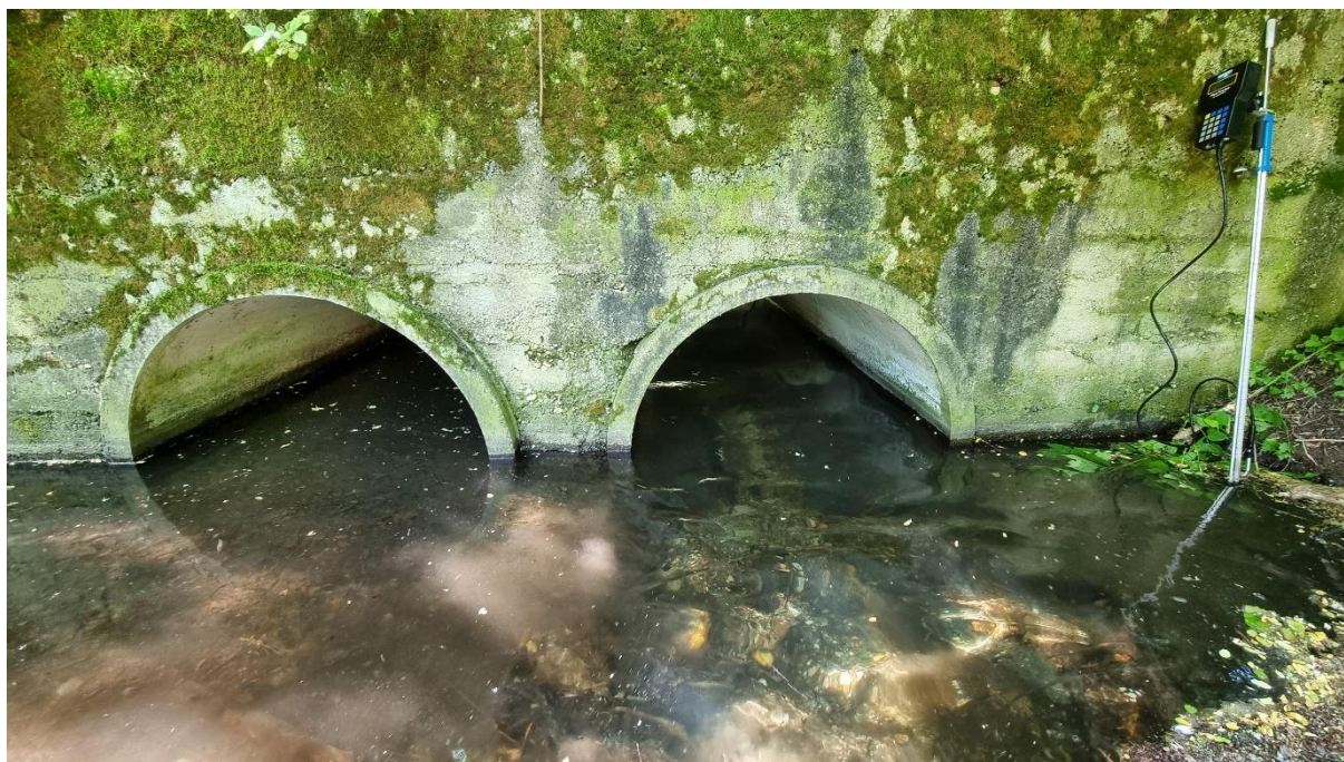
Obr. 10. Fotografia priepustov v rkm 22,400.
