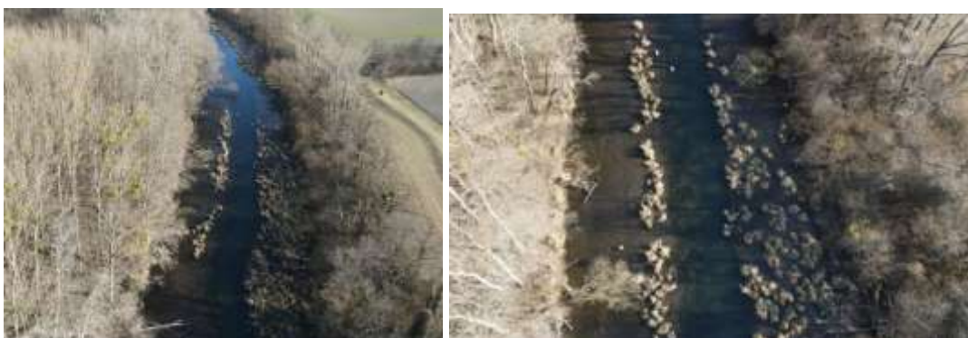
Obr. č. 69 Ukážka prírodou vytvorené zúženie pôvodného koryta Klátovského ramena
