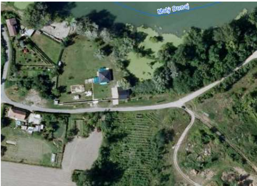
Obr. č. 16 Ukážka zástavby 1. úseku
