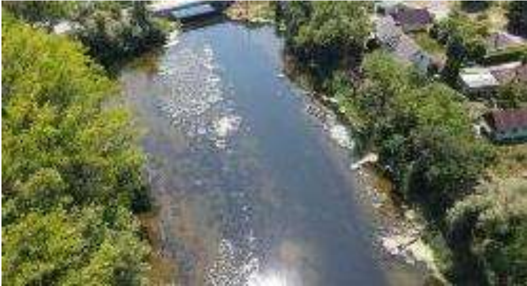
Obr. č. 25 Mostný objekt v obci Trhová Hradská
