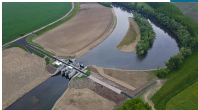
Obr. 5.12 Ostrov a zátvorný objekt na Klátovskom ramene (Hanzlík, 2022)
