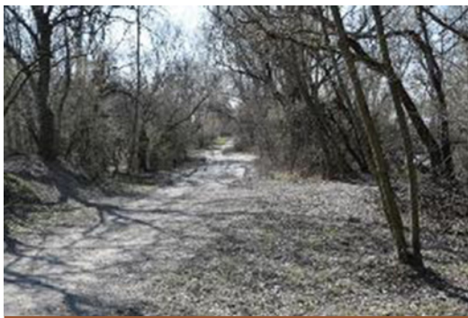
Obr. 6.37 Problematické miesto prúdenia v toku vytvorené presypom pre poľnú cestu
