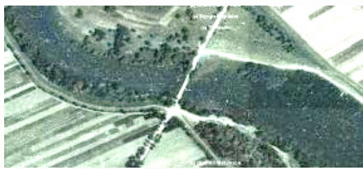
Obr. 5.35 Most v obci Trhová Hradská pred rokom 1960
