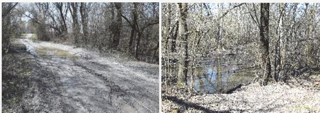
Obr. 6.33 Problematická poľná cesta presypom križujúca tok bez priepustu
