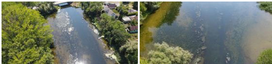
Obr. 5.34 Rozšírenia koryta zanesené sedimentami pred a za mostom – Trhová Hradská
