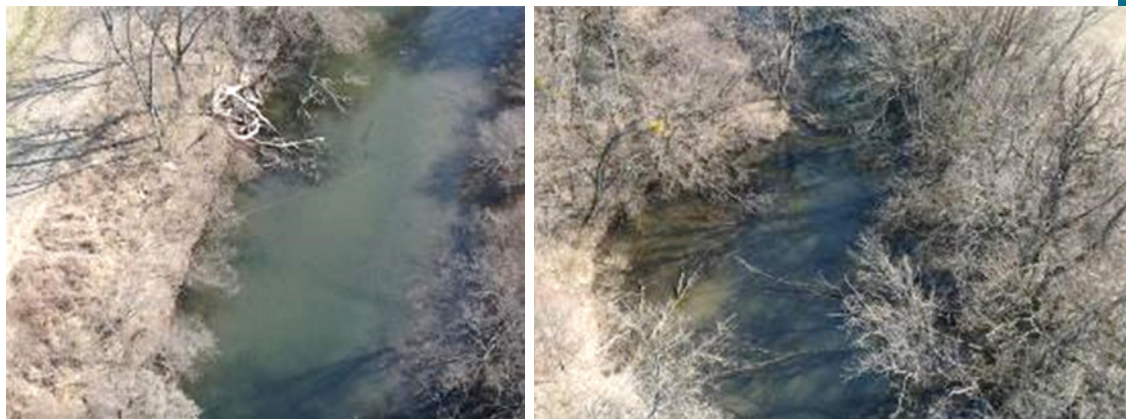
Obr. 5.64 Prietoknosť koryta je ovplyvnená spadnutými stromami
