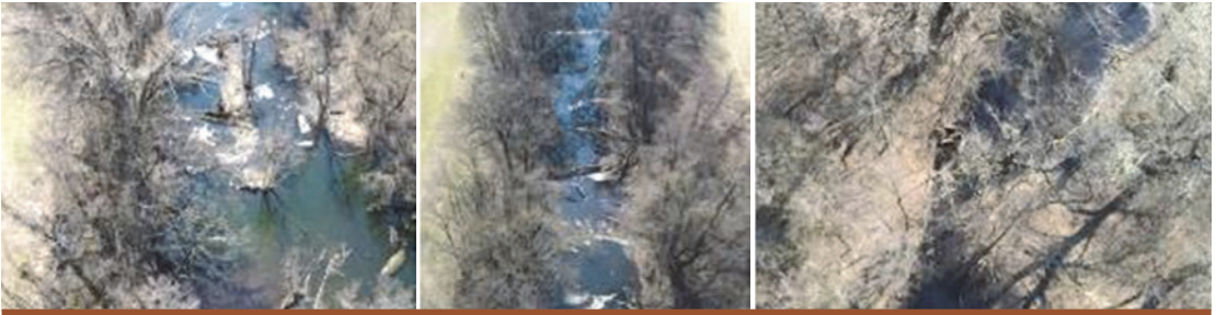
Obr. 6.30 Problematické miesta prúdenia v toku
